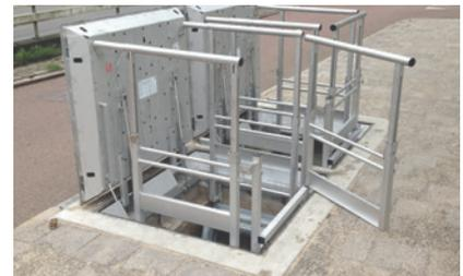
Ein selbstschließendes Türelement im Geländer, ermöglicht den sicheren Zugang zur Schachtöffnung.
